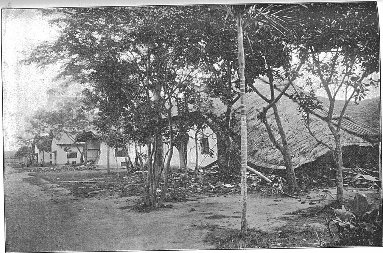
斗六守備隊内の家倒壊
