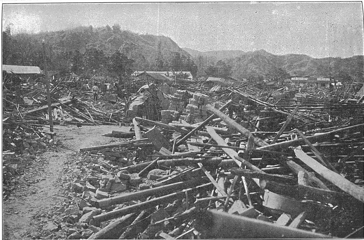
梅坑仔街の慘狀(山腹に陥りたる處あり)
